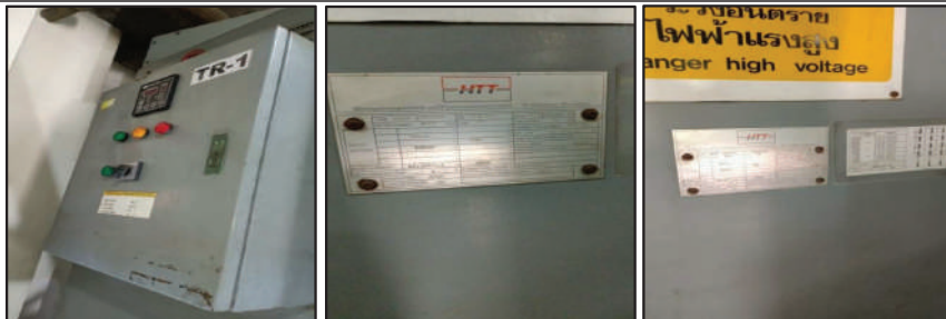
หม้อแปลง Dry Type TR.1 อาคาร B
