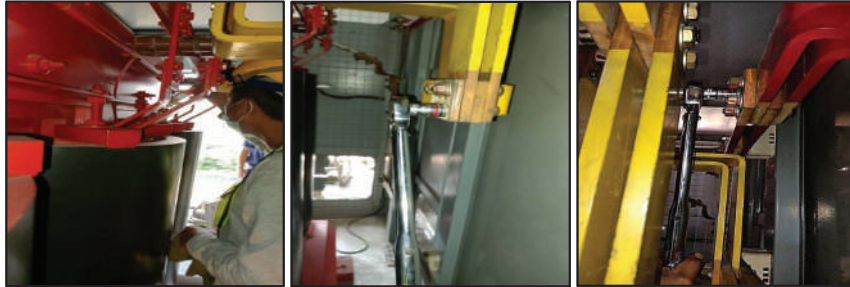
กวาดชั้นเนื้อจุดต่ออุปกรณ์หม้อแปลงไฟฟ้า
