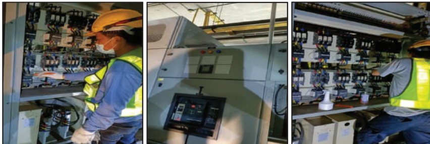
ทำควมสะอาดตู้ CAPACITOR BANK
