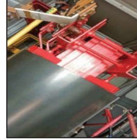
วัดค่าเมกเกอร์หม้อแปลงไฟฟ้าด้านแรงสูง - แรงต่ำ ได้ 107 GΩ
