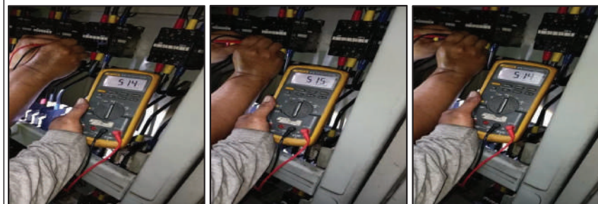
ช่างได้ทำการวัดค่า CAPACITOR BANK
