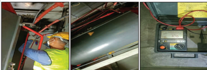
วัดค่าเมกเกอร์หม้อแปลงไฟฟ้าด้านแรงสูง - แรงต่ำ ได้ 106 GΩ
