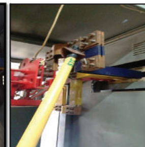
ใช้ไม้ขีดกราวด์เพื่อให้อิฟลงกราวด์ ป้องกันกระแสไฟฟ้าคงค้างหม้อ
