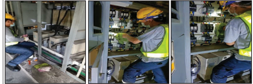
ทำความสะอาด และฉีดน้ำยาไล่ความชื้นอุปกรณ์ตู้ MDB
