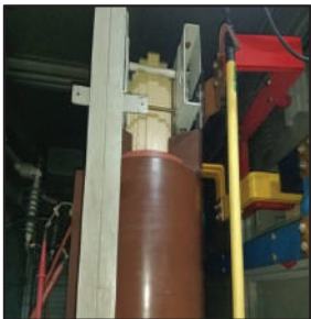
วัดค่าเมกเกอร์หม้อแปลงไฟฟ้าด้านแรงสูง - แรงต่ำ ได้ 47.5 GΩ
