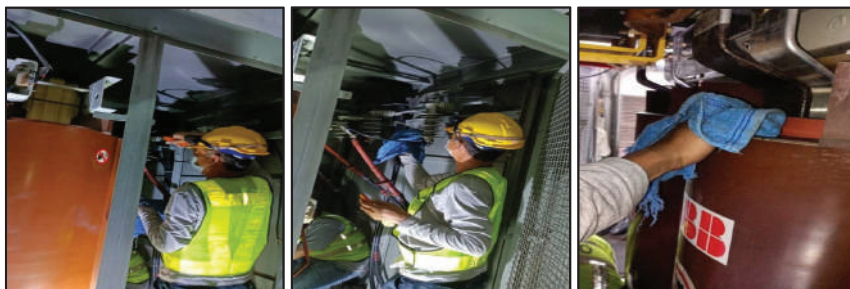
เช็ดทำความสะอาดหม้อแปลงไฟฟ้า พร้อมฉีดน้ำไล่ความชื้น
