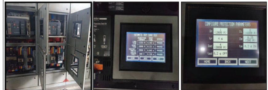
ทดสอบ Function Trip Unit
