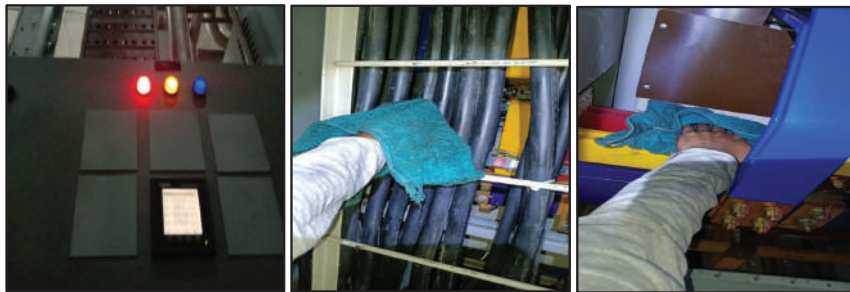
เช็ดทำความสะอาดสายแรงต่ำ และบัสบาร์
