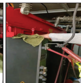
เช็ดทำความสะอาดหม้อแปลงไฟฟ้า
