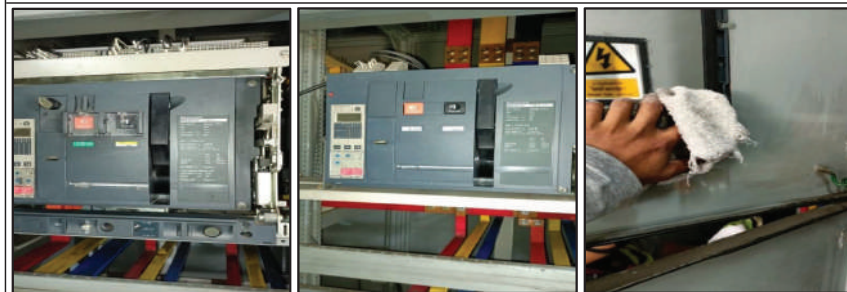
เช็ดทำความสะอาด พร้อมฉีดน้ำยาไล่ความชื้น
