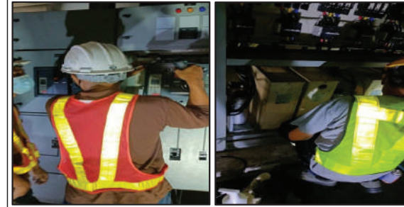
กดขันน็อตจุดต่ออุปกรณ์ พร้อมฉีดน้ำยาไล่ความชื้น
