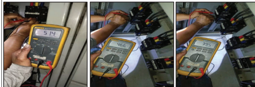
ช่างได้ทำการวัดค่า CAPACITOR BANK
