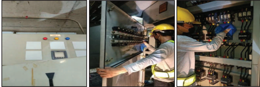
ตรวจเช็คสภาพภายนอกอุปกรณ์เบรกเกอร์และอุปกรณ์ตู้ MDB
