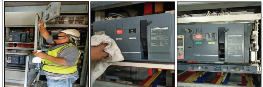
เช็ดทำความสะอาด พร้อมฉีดน้ำยาไล่ความชื้น
