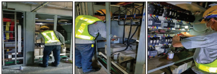
ตรวจเช็ค ทำความสะอาดอุปกรณ์ตู้ MDB
